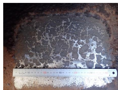
図-2 ダイヤモンドディスクにより処理した対象面
