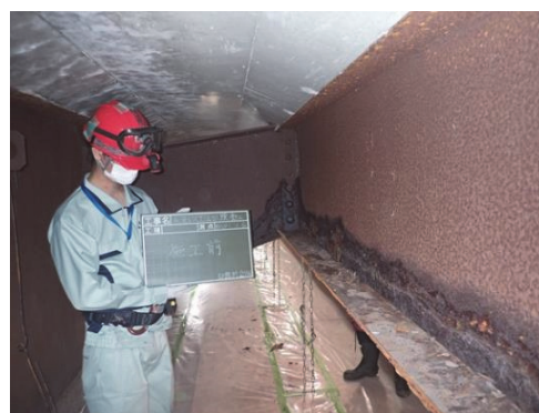
写真1 補修箇所施工前の状態
