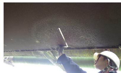
図2 床版下面の漏水周辺の腐食状況
