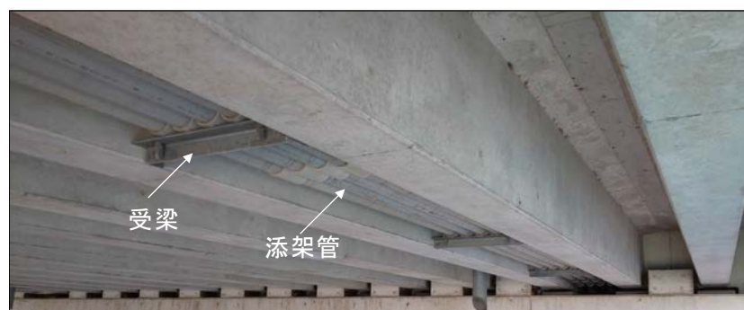
図.1 計測した橋梁および添架管
