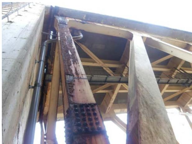
写真-1 鉛直材の腐食損傷状態
