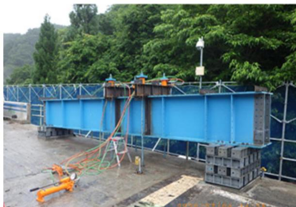
写真-2 軸力除去装置（橋面上）
