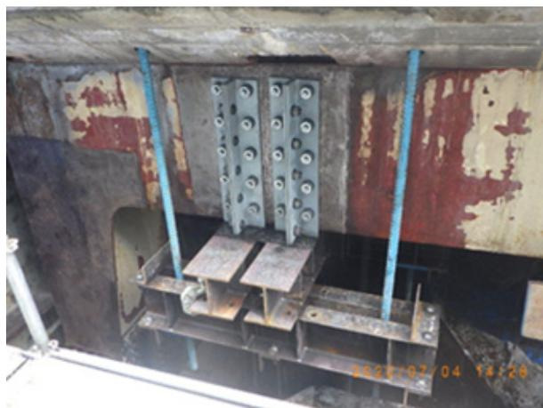
写真-3 軸力除去装置（上弦材側）
