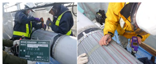
写真-1 調査状況
