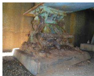
写真1 鋼製支承の腐食 図1 回転不良のイメージ図
