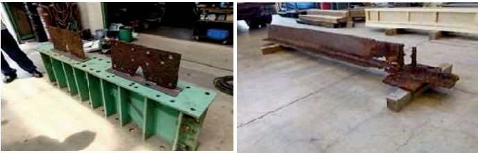
写真-1 腐食鋼板 写真-2 実橋腐食桁
