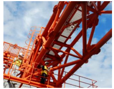
写真－2 点検の様子
