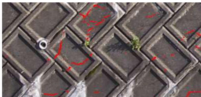
図1 コンクリート護岸のひび割れ検出結果
