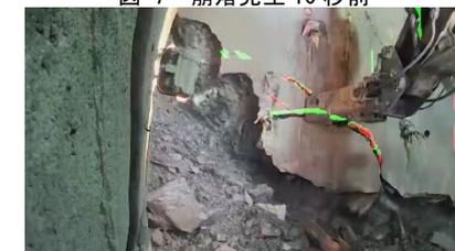
図-8 崩落発生の瞬間
