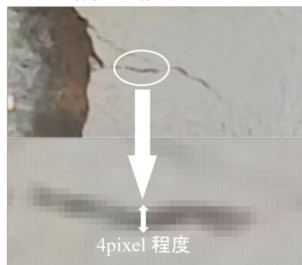
図-3 崩落前のクラック幅
