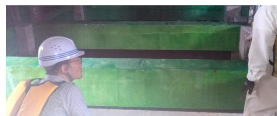
アラミド繊維での桁の補強例
