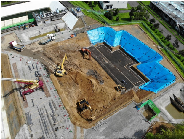
写真-4 丁張レス掘削全景
