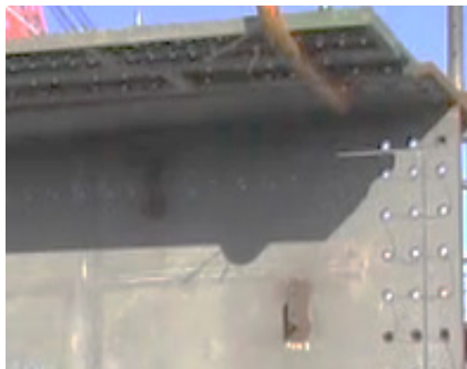
(a)実物の鋼桁
