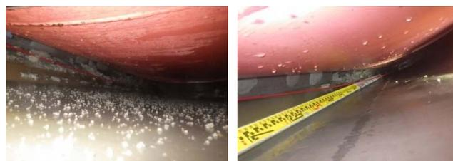
図 6 配管清掃ノズルによる除去後の状況
