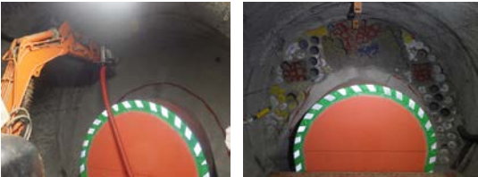
図 7 掘削状況 (左: 掘削直前, 右: 掘削後)
