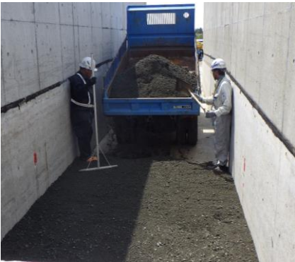
写真1 敷均し（下部覆土）
