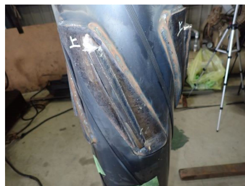
写真-3 セントライザ溶接後
