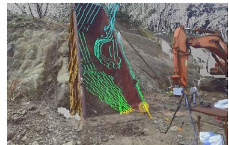
図-4 システム上で重ね合わせた点群データのリアルタイム表示
