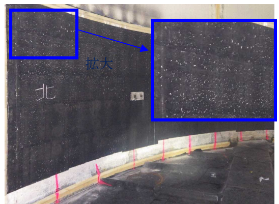
写真-1 レーザー除染後のタンク内部状況
