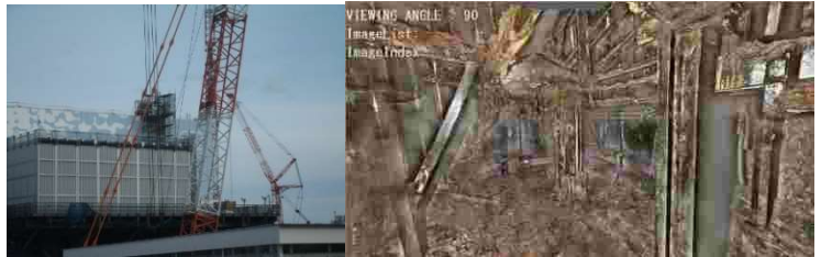
左：2号機原子炉建屋（2020年1月14日）右：2号機原子炉格納容器内ペDESTAL底部（出典：東京電力ホールディングス）
