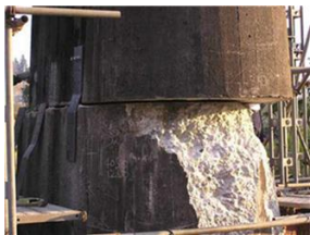
図1 新潟県中越地震で被災した魚野川橋梁 14P 橋脚 1)
