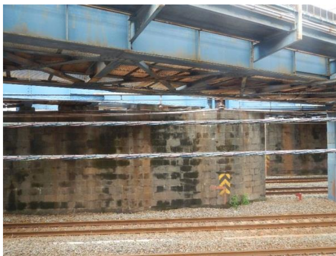
図-1 対象となる無筋橋脚
