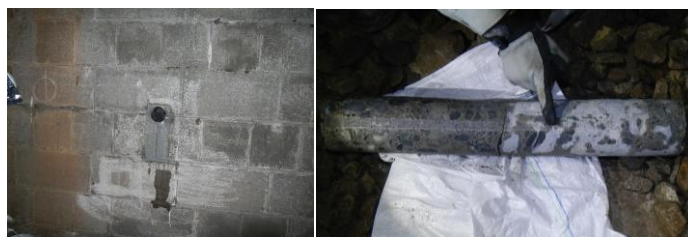
図-2 コア削孔による橋脚内部調査
