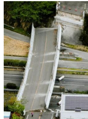
(a) 橋台上面の擦過痕軽微 図10 橋桁の異常な落下
