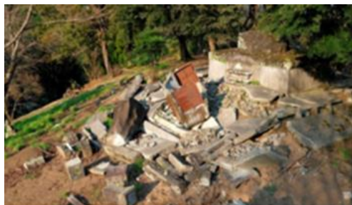
図7 辻ヶ峰の慰霊碑と施設の飛散状況 熊本地震(2016,M7.3)
