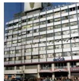
兵庫県南部地震 図14 層間破壊例(2)
