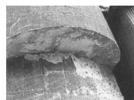
(a) JR 魚野川橋脚上半のずれ (b) 整然と並ぶ大根 図6 中越地震(2004,M6.8)での飛び跳ね現象(北西) 5)
