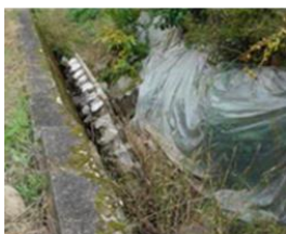
地表断層交差部 図8 水路護岸の反転
