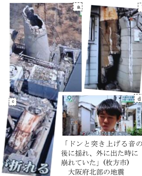
図11 煙突の3分割破壊と証言
