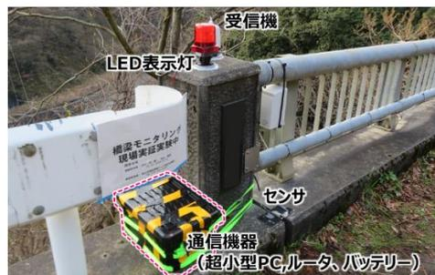
写真-3 通信機器の設置状況
