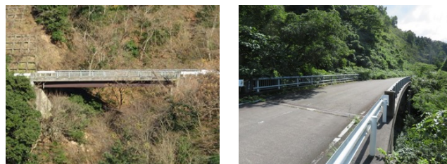
写真-1 対象橋梁
