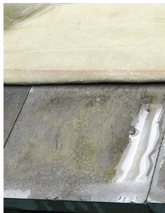
写真3 散水完了時 (湿潤率約 100%)
