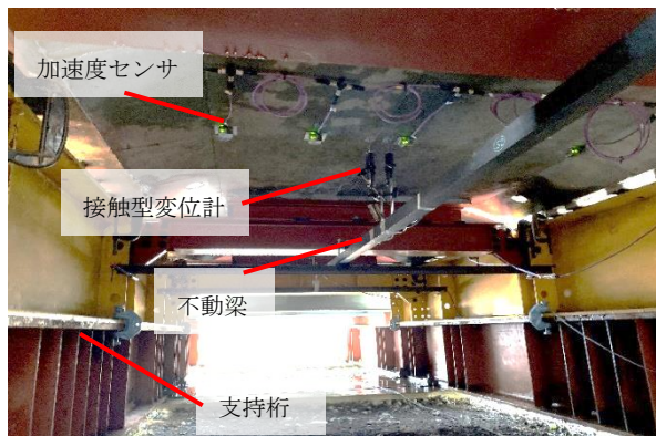
図3 センサ設置状況
