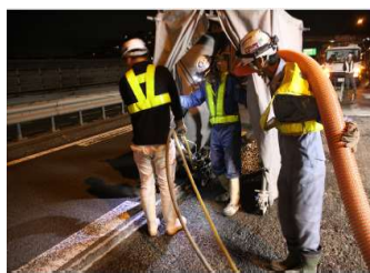
写真-2 WJ 施工状況
