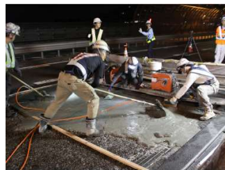
写真-4 敷均し状況
