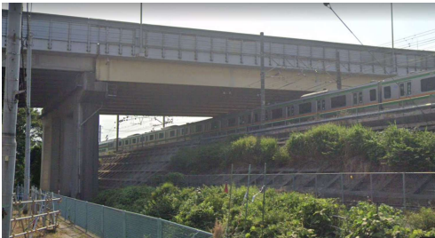
写真-1 法泉高架橋
