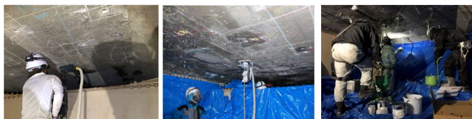
写真-4 削孔状況
