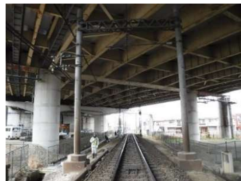
写真-1 着手前写真
