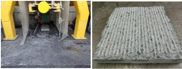
写真－1 定置式切削装置および切削面
