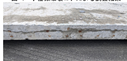
写真-3 撤去床版（橋軸方向断面）
