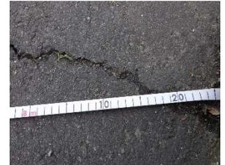
写真 4-2 舗装ひび割れ
