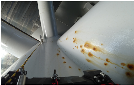
写真-4 「やもりん」の栈橋杭撮影状況
