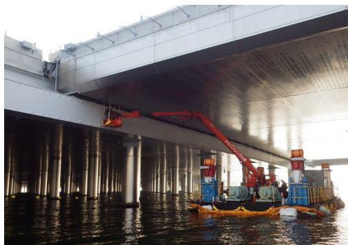
写真-1 棧橋杭近接目視点検
