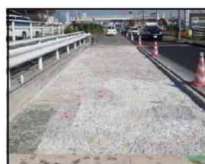
(3)損傷部ハツリ完了
