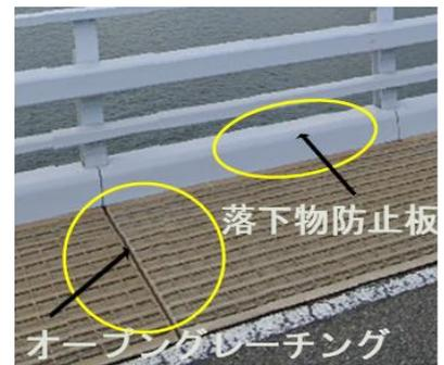
図1 オープングレーチングと落下物防止板
