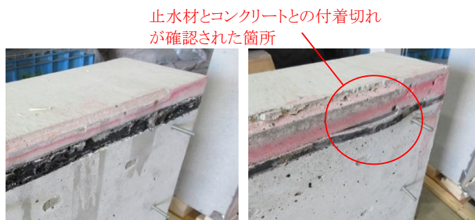
＜B: 反応接着型＞ 止水材とコンクリートとの付着状況 ＜C: 水膨張ゴム＞
