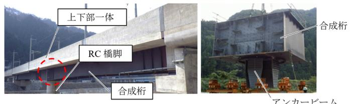
(a) 中間支承を省略した合成桁 (b) 接合部の鋼部材
