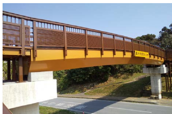
図 1 浦添公園歩道橋
