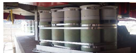
写真－2 簡易段差防止の設置状況
