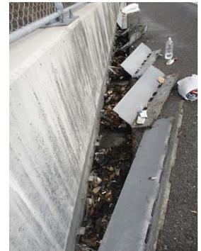
写真-1 鋼製排水側溝の閉塞事例
