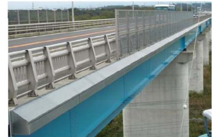
写真-4 地覆外側の鋼製排水側溝事例<sup>6)</sup>
