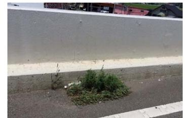
写真-3 閉塞した排水柵事例
