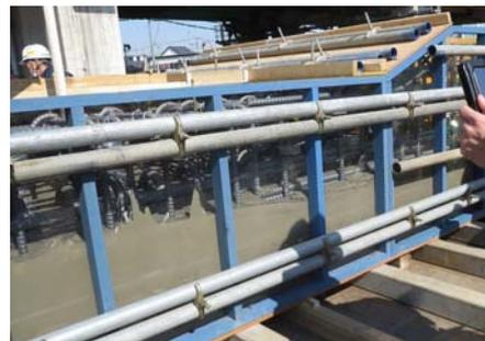
写真-1 コンクリート充填状況
