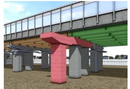
図-1 拡幅後のランプ橋下部工
