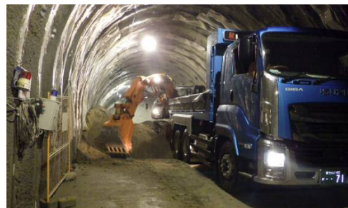
写真－2 ずり搬出状況（トンネル内）
