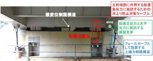
図-3 支承部の構造の見直し
