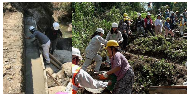
写真4 コンクリート打設状況
