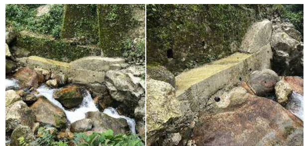
写真5 雨季後の擁壁の状況(劣化・損傷なし)
