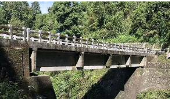
写真 1 KatleyⅢ橋（左岸上流側より撮影）
