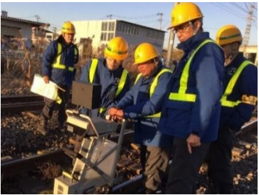
写真-2 レール探傷 OJT 実習
