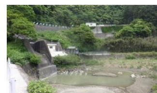
図4 安房中央ダム放水口下
