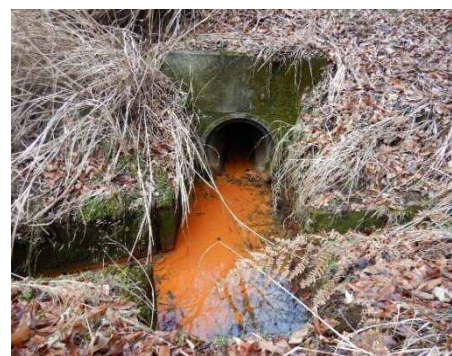
図-3 高速道路上流部の呑口付近
