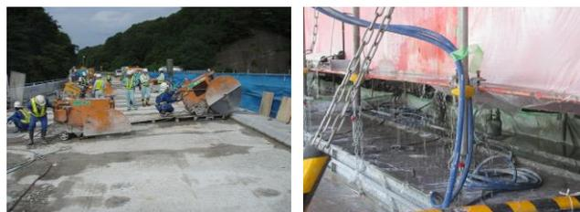
図-1 床版取替工事での汚濁水の発生
