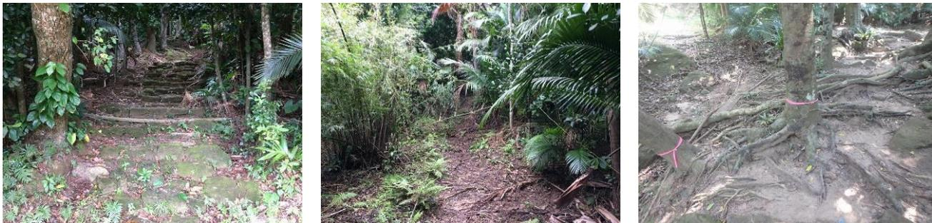
写真-2 事業実施前の避難路（左：階段部、中：土羽部、右：樹木の根が複雑に伸長する階段部と土羽部の中間部）
